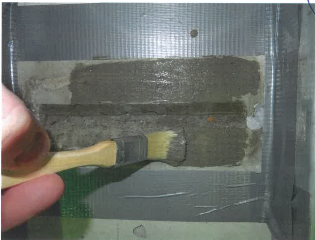
Bild 4 Auftrag der 1. Lage der Dichtungsschlämme Crystal-Proof L1
