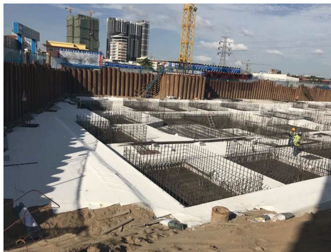
Bild 1 Endkontrolle bei -6°C: Verlegung Planotite XF® in einem neuen Gewerbezentrum im Hafenrandgebiet
