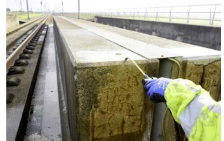
(3) Flächensanierung mit einer Lösung, die auf Risse aufgesprüht werden kann
