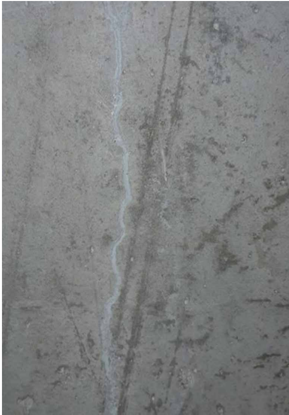
Bild 2 Mit Krystaline behandelter Riss
