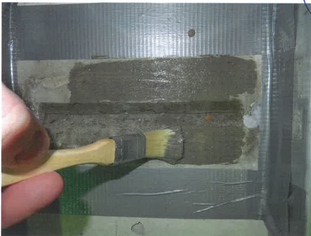
Bild 4 Auftrag der 1. Lage der Dichtungsschlämme Crystal-Proof L1
