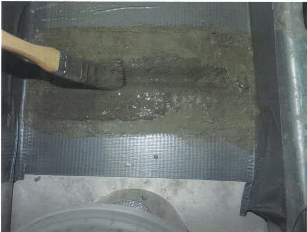
Bild 5 Auftrag der 2. Lage der Dichtungsschlämme Crystal-Proof L1
