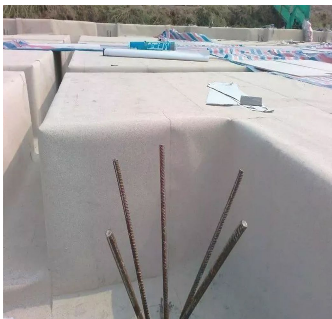
Bild 2 Planotite XF® ist eine besonders elastische HDPE-Membran. Sie lässt sich fast wie eine Haut an schwierige Untergründe anpassen. Gleichzeitig ist sie dennoch extrem belastbar und unempfindlich gegen mechanische Verletzungen
