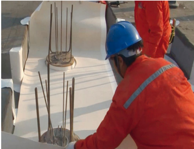
Bild 3 Ausgeschnittene Krägen umkleiden die Bohrpfähle bevor die Längsbahn darauf verklebt wird. Planotite XF® kommt ohne aufwändige Extras aus und sorgt für eine kostengünstige, zügige Verlegung.
